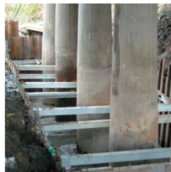
橋梁耐震補強工事
