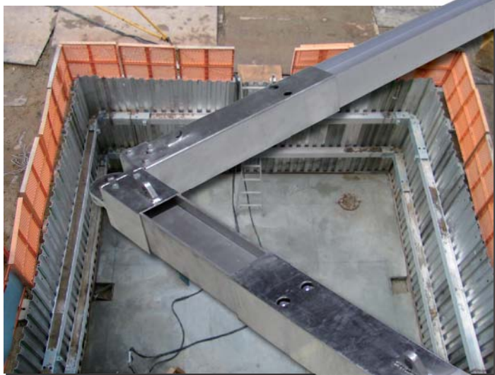
エレベーター基礎工事 (W5115×L5600×H2550)
