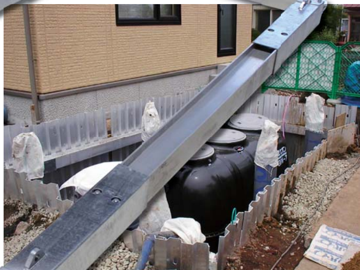
浄化槽設置工事 (W2640×L5180×H2100)
