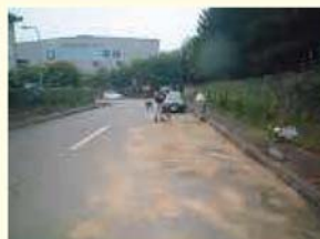
オイルを吸着したオイルゲーターを回収している状況。
