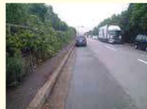
回収処理後の状況。雨が降っても油膜は発生せず。
