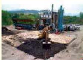
油が含まれた土壌の改良
