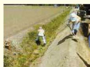
土水路の中に作動油がこぼれたのでオイルゲーターを使用し、早期処理を行い、油分の流出を防いだ。(作動油7リットル程度にオイルゲーターを4kg程度撒き処理)
