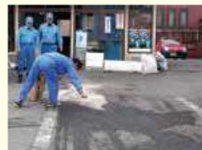
舗装面へこぼれた油の除去
