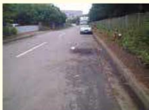
違法駐車車両からの油漏れ。舗装面にオイルが飛散している状況。
