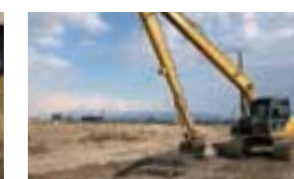
災害復旧工事 (富山県)
