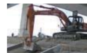
築堤護岸工事 (東京都)
