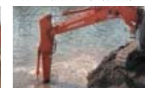
河川整備工事 (和歌山県)
