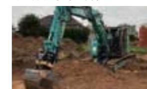
掘削工事 (海外)
