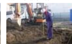
住宅基礎工事 (山梨県)
