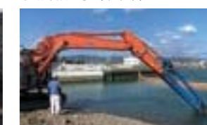
護岸整備工事 (和歌山県)
