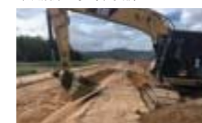
農地法面整正工事 (北海道)
