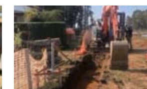
水路布設工事 (千葉県)
