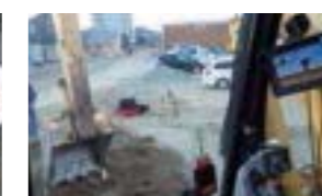
床付け工事 (神奈川県)
