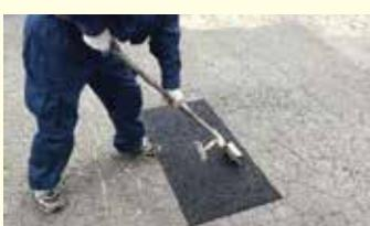
路面貼付後、丁寧に足踏みするか、手押しローラ、タンパ、木槌などでマット表面に満遍なく圧力を加え路面と密着させる。
