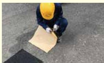
マット裏面のはく離紙を四角の角からつまみ上げて、斜め方向にマットと平行に引っ張る。夏季に粘着が強い時は、コールドスプレー や凍らせたペットボトルで冷やす。
