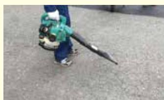
補修箇所を送風機、箒などで清掃し、埃や砂利を取り除く。路面がぬれている場合は乾燥させてから作業を行う。
