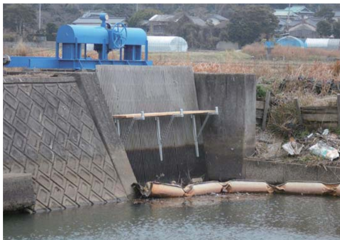
上水道取水口に常設
