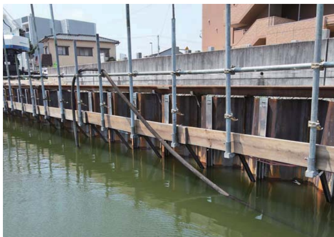
鋼矢板 延長バー 外掛け
