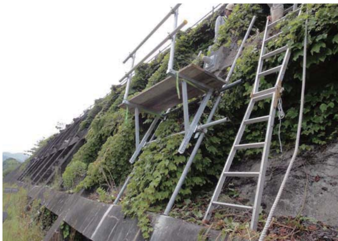
法枠アンカー検査用足場
