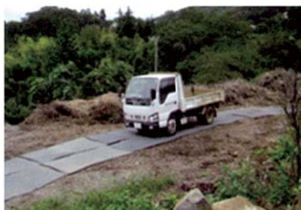
仮設通路・道路の設置
