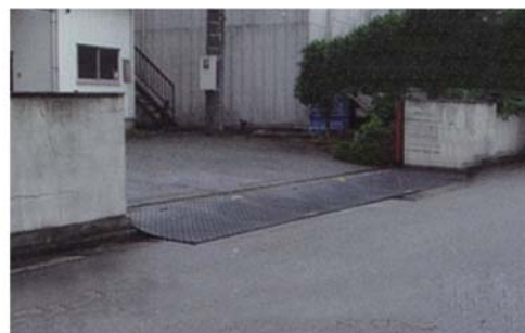
道路段差補修
