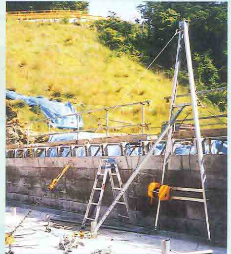
スライド君にて、本柱とメタルと足場を引き上げ
